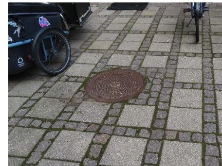
Kloakbrønd i gård
