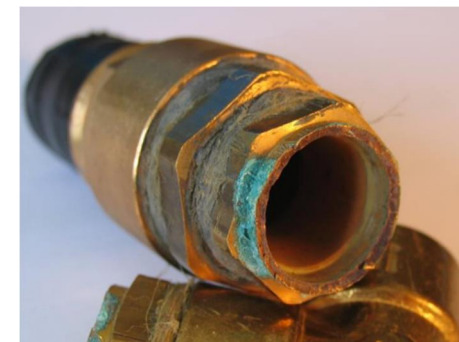
Eksempel spændingskorrosion i messingfitting
