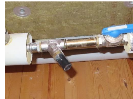
Termostatstyret cirkulationsventil
