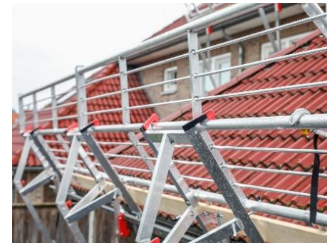
Eksempel på faldsikring monteret i tagrende
