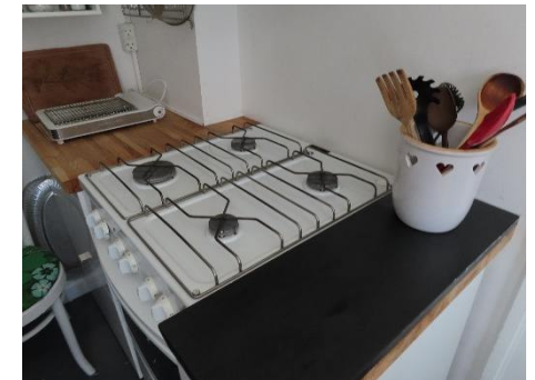
Gasrør i kælder
