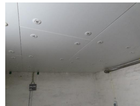
Eksempel på pladebeklædning
