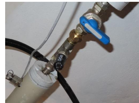
Termostatstyret cirkulationsventil
