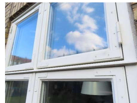
Koblet vindue med kitfalsede ruder
