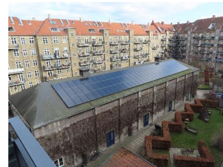
Solcelleanlæg på biografbygning
