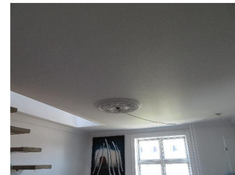
Loft uden revner
