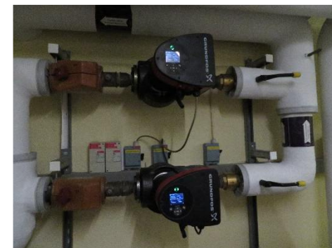
Cirkulationspumpe
