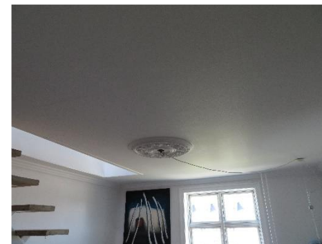
Loft uden revner
